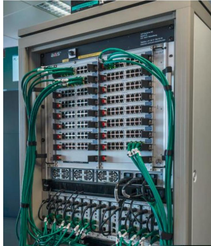
*Die Rechner werden mit der KVMA Technik in der Regel in 19 Zoll Racks montiert und verkabelt.*
